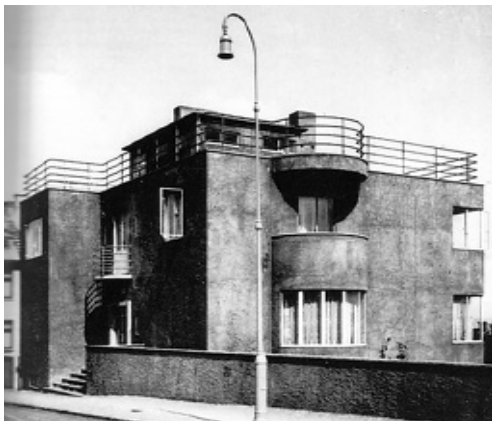
E. (above): Sigurdur Gudmundsson. Villa Garðastræti 41 , Reykjavík, 1929.
